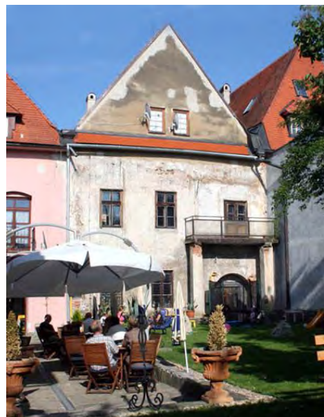
Reštauračné posedenie v dvornom trakte domov na Radničnom námestí
