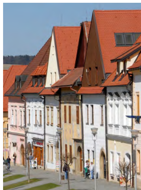
Obnovené meštianske domy v juhozápadnej časti Radničného námestia
