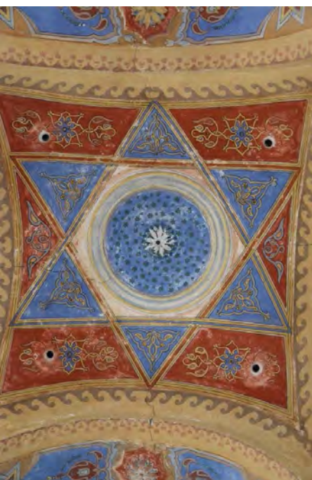
Malba stropu Starej synagógy po reštaurovaní
