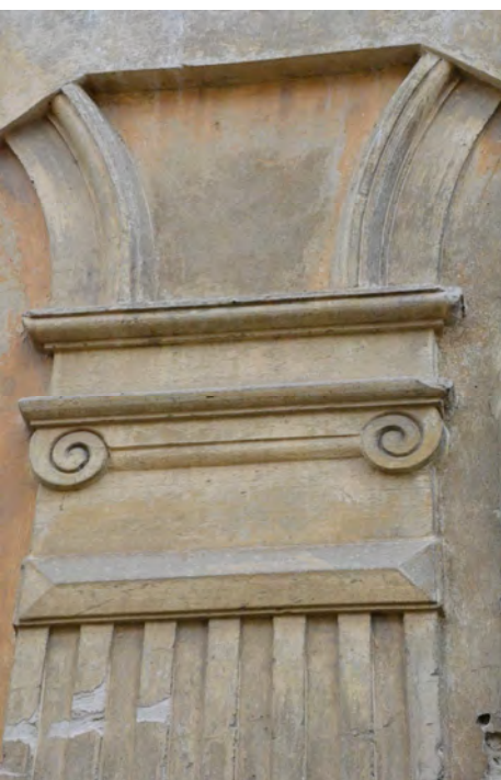
Detail štukovej výzdoby fasády budovy školy (dom štúdia)
