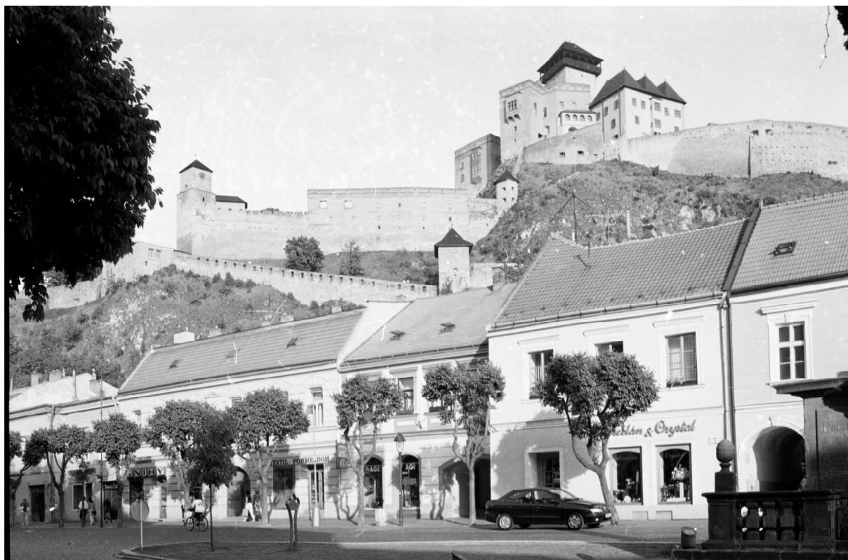
Obr.4: Stav Trenčianskeho hradu po pamiatkovej obnove, 2001. (Zdroj: Archív PÚ SR)
