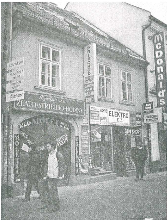
Fasáda objektu je ukrytá pod spleťou reklamných prvkov, Obchodná ul., PZ Bratislava
