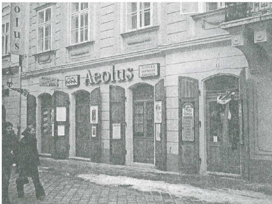
Vhodné umiestnenie reklamy na vnútorných stranách okeníc mestského paláca. Panská ul., MPR Bratislava
