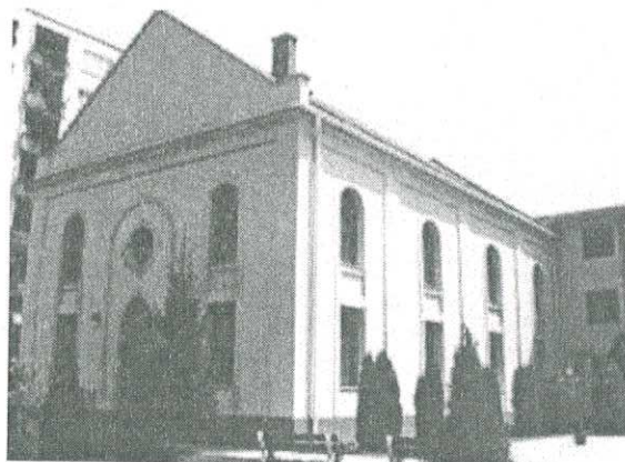
Obr. 8,9,10 - ortodoxná synagóga v Komárne s novotvarom prístavby pre potreby Domova opatrovateľskej služby, adaptácia funkcie vyvolala nežiadúce zásahy do dispozície a konštrukcie
