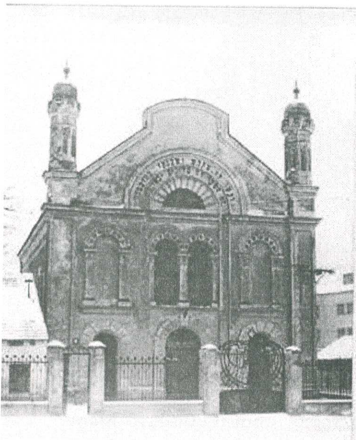
Obr. 14 - Pezinok, synagóga, čelná fasáda (archív PÚ Bratislava)
