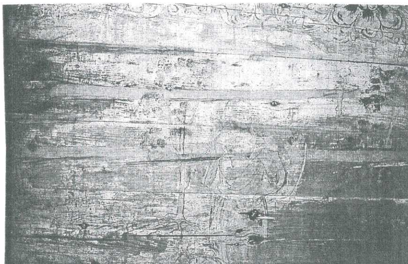
Kościół św. Leonarda w Lipnicy Murowanej. Nawa, ściana północna, przed konserwacją.
