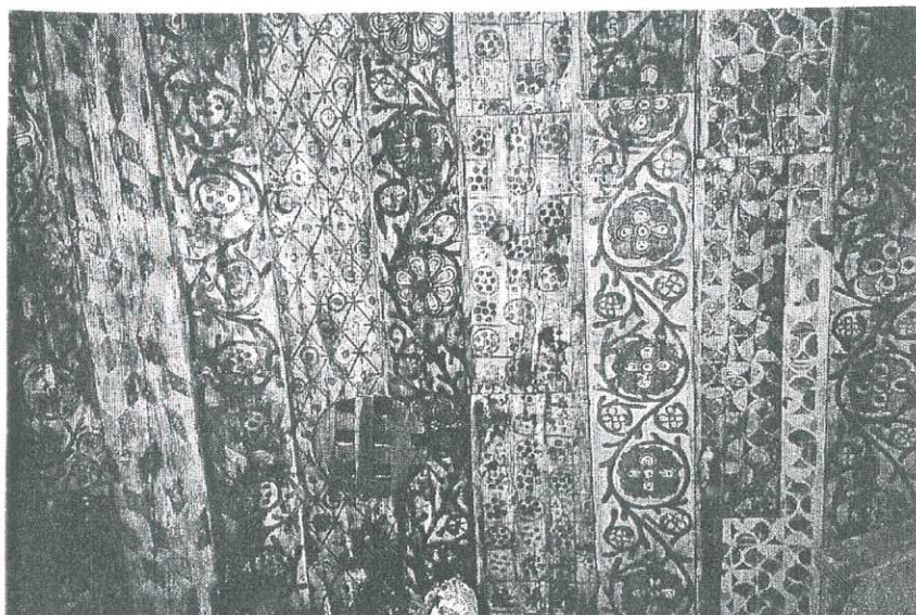
Kościół św. Leonarda w Lipnicy Murowanej. Prezbiterium, sufit, przed konserwacją.
